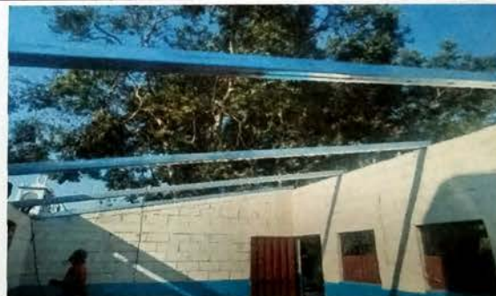
Foto 4: MODULO B Vista interior de aula con instalacion de vigas de metal de seccion cuadrada colocadas a lo ancho del modulo
