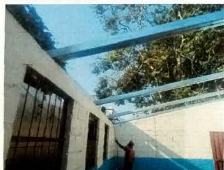
Foto 3: MODULO B Vista interior de aula con instalacion de vigas de metal de seccion cuadrada colocadas a lo ancho del modulo.
