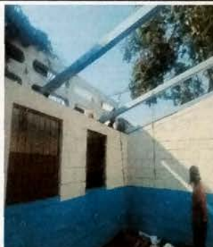
Foto 2: MODULO B Colocacion de Vigas de metal en sentido transversal.
