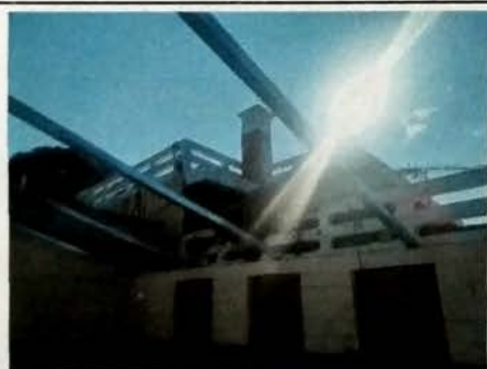
Foto 5: MODULO B Vista muro de fondo con colocacion de vigas de metal de seccion cuadrada colocadas a lo ancho del modulo
