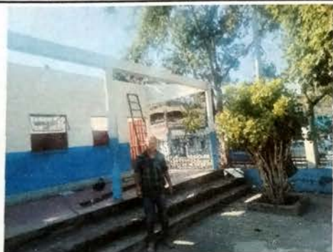
Foto 1: MODULO B AULA Vista Desmontaje de estructura en mal estado
