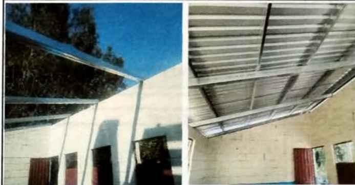
Foto 8: MODULO B Vista Frontal desmontaje de lamina de zinc en mal estado. Vista interior muro de fondo y lateral izquierdo Instalacion de vigas de metal de seccion cuadrada en sentido transversal.
