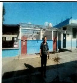
Foto 9: MODULO C Vista Frontal desmontaje de lamina de zinc en mal estado.
