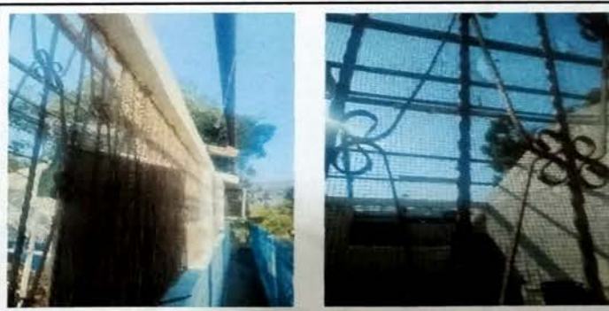
Foto 10: MODULO C Vista Posterior desmontaje de lamina de zinc en mal estado.
