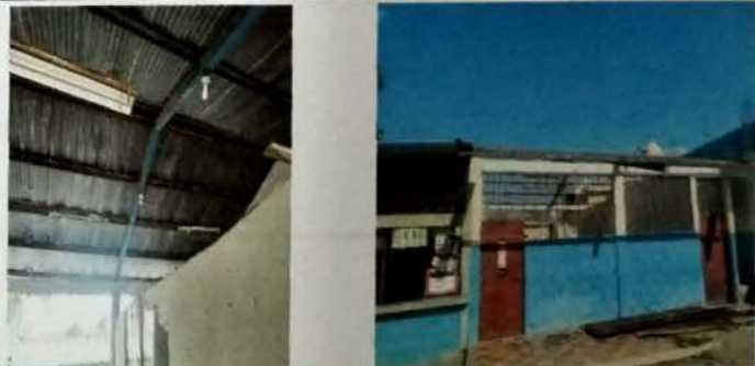
Foto 12: MODULO C Vista Frontal desmontaje de lamina de zinc en mal estado.
