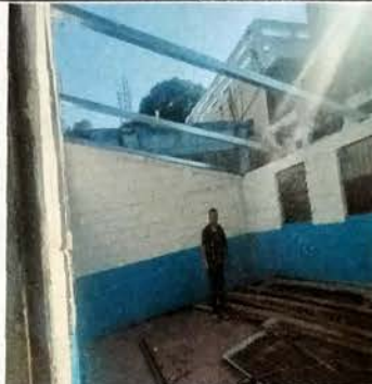
Foto 2: MODULO B Colocacion de Vigas de metal en sentido transversal.
