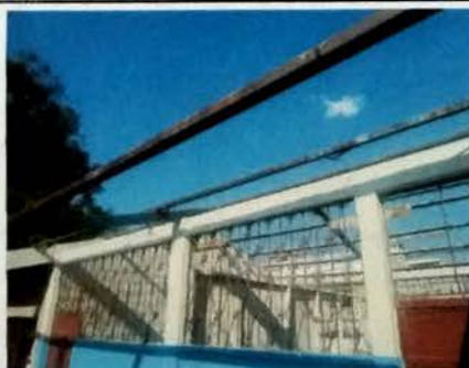
Foto 11: MODULO C Vista Frontal desmontaje de lamina de zinc en mal estado.
