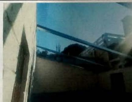
Foto 6: MODULO B Vista muro lateral izquierdo con colocacion de vigas principales de metal de seccion cuadrada colocadas a lo ancho del modulo
